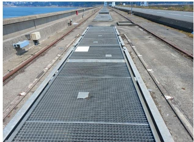
Ces ouvertures sont également utilisées par les plongeurs pour les travaux de grattage des rainures ainsi que les visites par drone.
