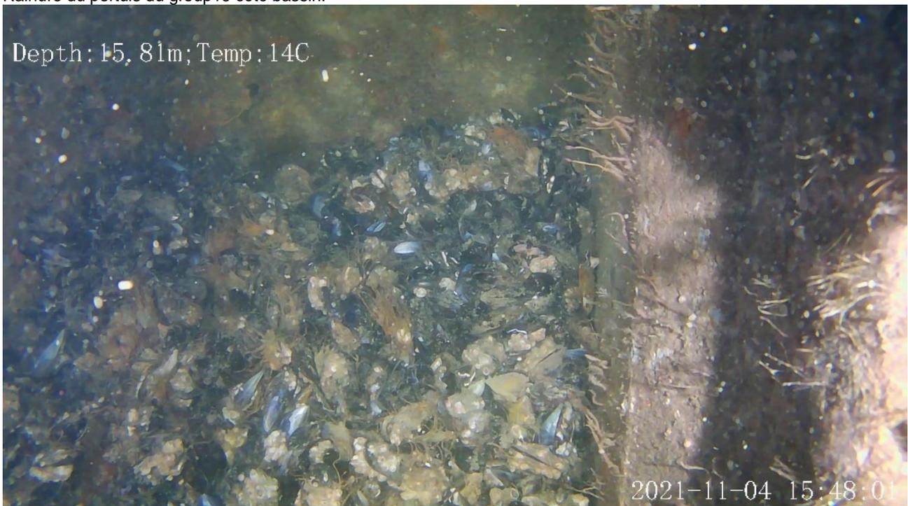
Accumulation de coquillages au fond de la rainure.
