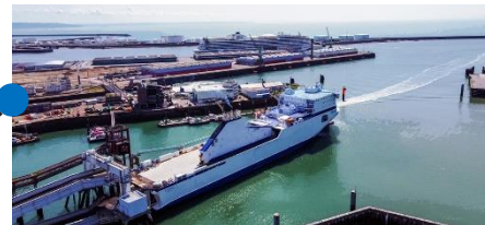
Alimentation à quai
